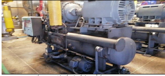
รูปที่ 6-1 Com#8 ตัวใหญ่ที่เคยเดินเครื่องในทุกๆครั้ง ที่ผ่านมาก ( ขนาด 225 kw )
