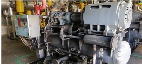
รูปที่ 6-2 Com#1 ตัวเล็กใช้เดินแทนตัวใหญ่ (ขนาด 150 kw)
